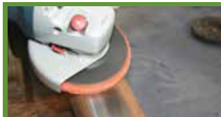
Entfernen von Belägen, Rost oder andere Korrosionen. Oberflächenvorbereitung vor dem Beschichten oder Schweißen.
